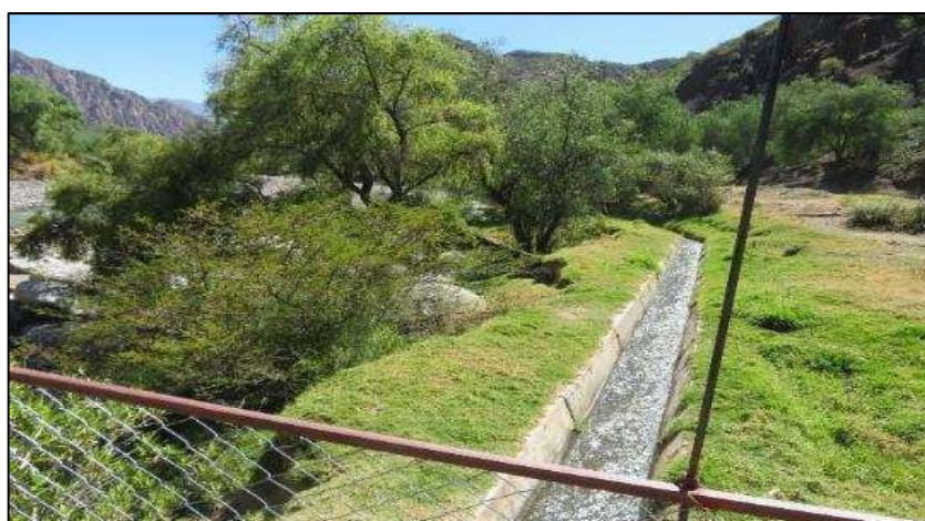
FIGURA N°03: VISTA DE LAS INFRAESTRUCTURAS VIALES Y DE CONDUCCIÓN EN EL SECTOR "ANDABAMBA", CONSTA DE CANAL DE CONDUCCIÓN DE MATERIAL CONCRETO SIMPLE.
